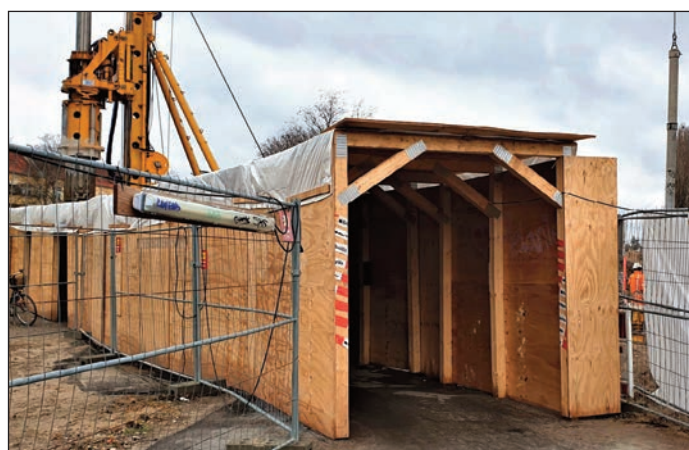
Am S-Bahnhof Lichtenrade wurde im Bereich des Fußgängerübergangs zur Prinzessinnenstraße ein provisorischer Fußgängertunnel errichtet.
