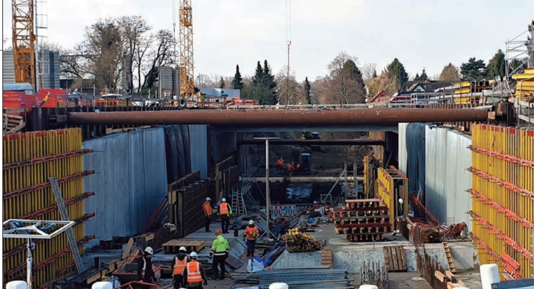
An der Säntisstraße ist die spätere Unterführung schon deutlich erkennbar.
