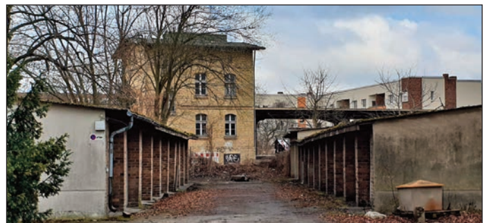
Das war einmal: Alte Garagen auf dem Gelände der Alten Mälzerei kurz vor dem Abriss.
